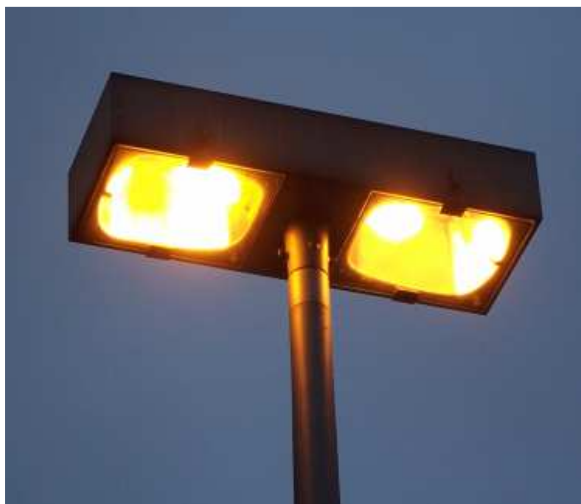
Abbildung 7: Leuchten der Deutschen Bahn AG
