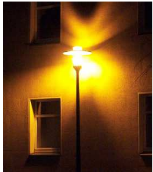
Abbildung 4: Bei dieser Leuchte wird ein Teil des Lichtes nach oben ungenutzt abgestrahlt.
