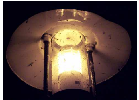
Abbildung 5: Diese Leuchte in Salzkotten ist von Insekten stark verdreckt.
